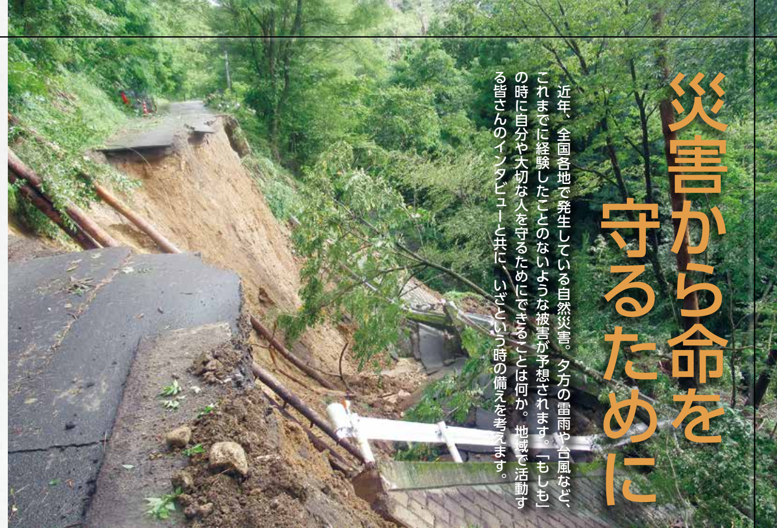
令和3年8月の台風による大雨で崩落した林道長峰線(現在は復旧)
