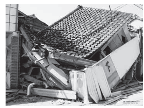
平成19年 能登半島地震で倒壊した住家 写真出典：財団法人消防科学総合センター
