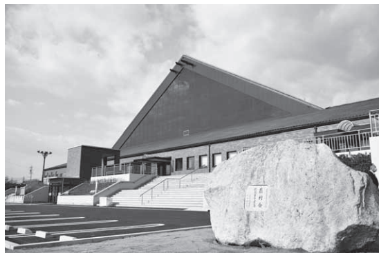
改修工事が完了した穂高会館
