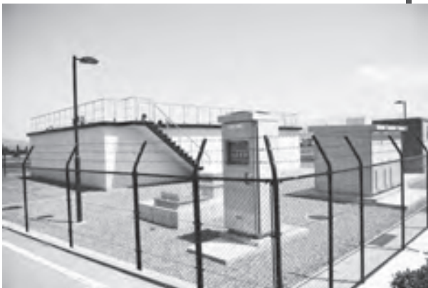
今回整備した野沢水源ポンプ場（三郷温）
