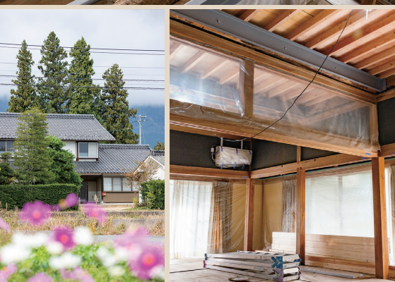
上：補助金を利用して梁を補強 左下：民家全景 右下：受け継がれた梁と柱を残しリノベーション
