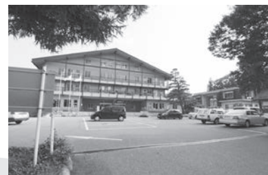
解体前の穂高支所
