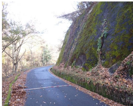
明科側から天平の森へ通じる長峰線。現状は車両のすれ違いが困難なほど狭いため、部分的に待避所を設置
