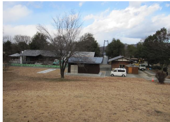
中央の改修後トイレ（R6改修）
