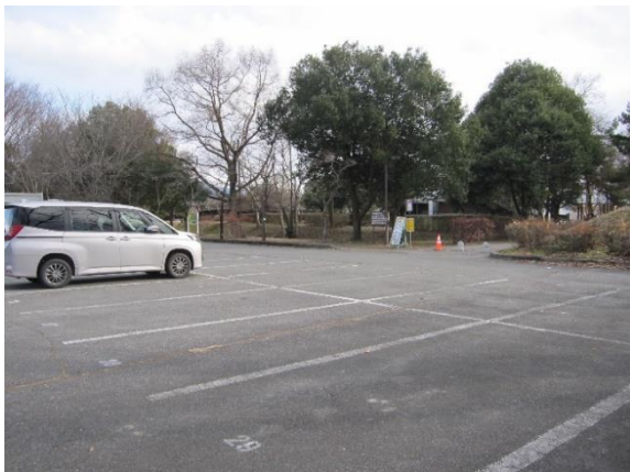
手狭な既存駐車場の様子。懸案だった駐車場のキャパシティを確保し駐車可能台数が42台⇒77台に増加予定（R7改修）
