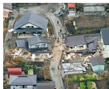
『被災時の様子』《写真提供：長野県》
