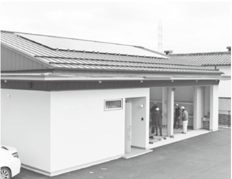
屋根にソーラーパネルが設置された第11分団第2部詰所
