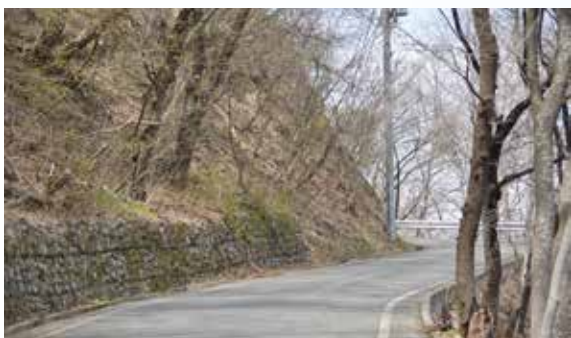
明科から長峰山へ向かう林道長峰線 すれ違いをスムーズにする待避所を設置
