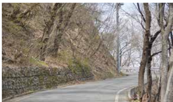
明科から長峰山へ向かう林道長峰線すれ違いをスムーズにする待避所を設置
