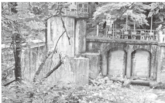
改修される須砂渡頭首工
