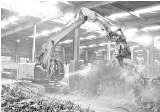
大型の重機を使って施設内のコンクリート擁壁を解体
