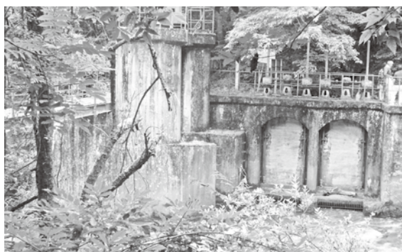
改修される須砂渡頭首工
