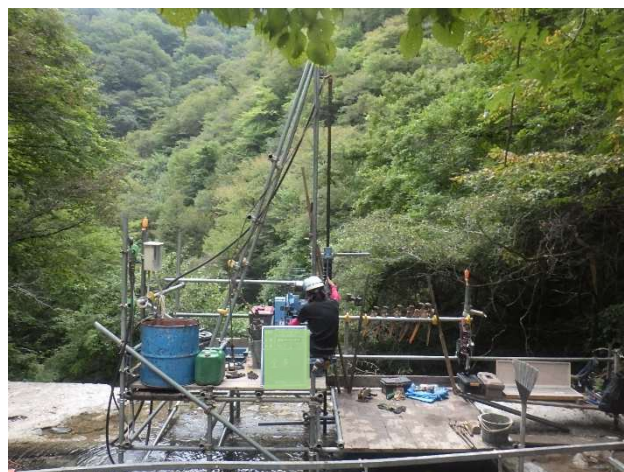
ボーリング調査状況
