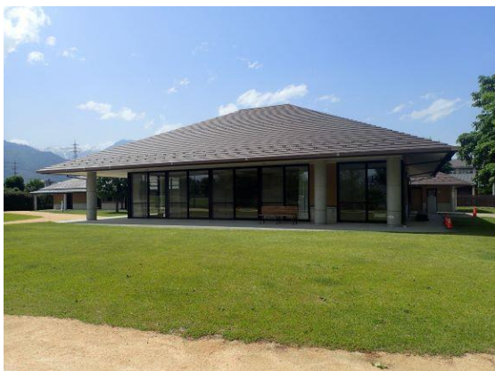
① ホール外から ※南側 (軒高3 m)
