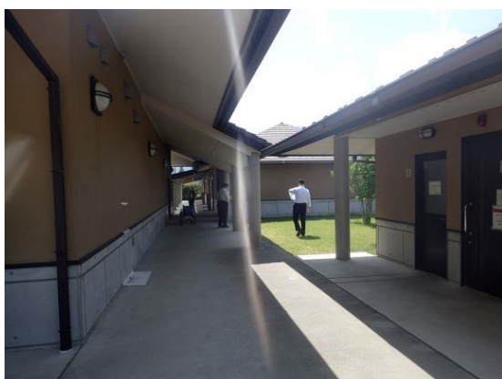
⑦ ホール北通路
