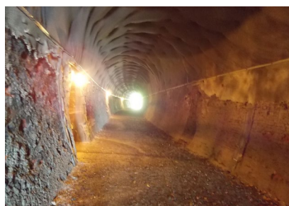
三五山トンネル
