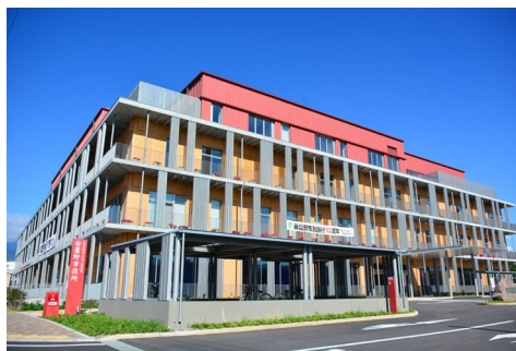
図2.51 新市役所本庁舎
