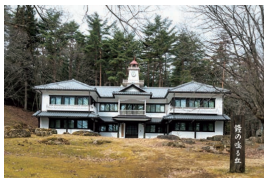
穂高鐘の鳴る丘集会所の大規模改修工事がしゅん工
