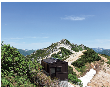
燕岳テント場トイレが完成・使用開始
