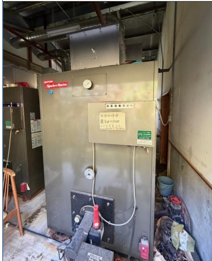
撤去予定ボイラー
