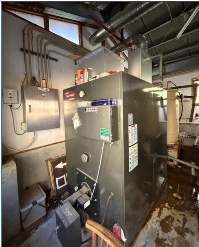
撤去予定ボイラー
