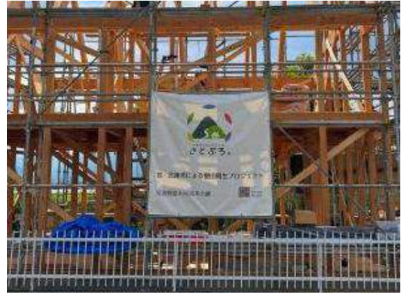
安曇野産材使用を示す建築現場の足場幕
