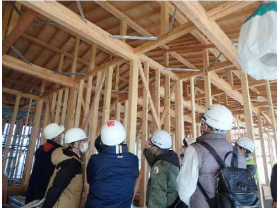
安曇野産材を使った三郷西部認定こども園 の新園舎建設現場を見学
