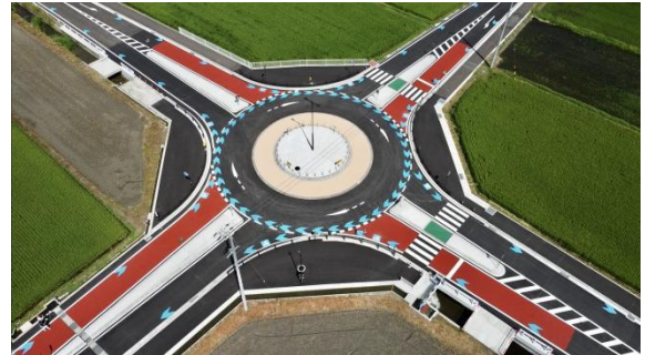
写真 6-2 市道 1 級 24 号線ラウンドアバウト
