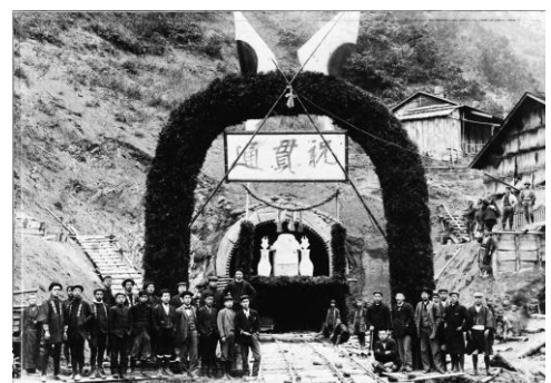
図4.32 第二白坂トンネル開通の記念写真
