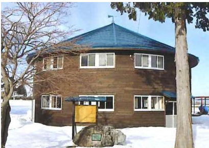
長野県南安曇農業高等学校 第二農場日輪舎
