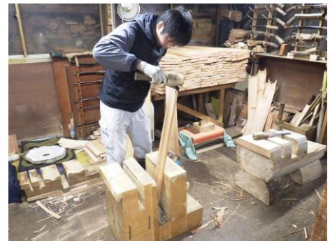
曾根原家住宅の屋根材更新のための へぎ板の加工
