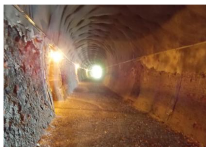
三五山トンネル
