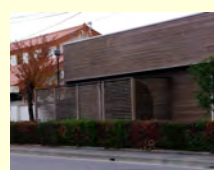
室外機に囲いを設置
