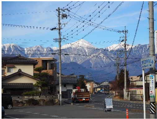
写真 4-2 国道147号本吉町交差点 (旧岩原道沿い)
