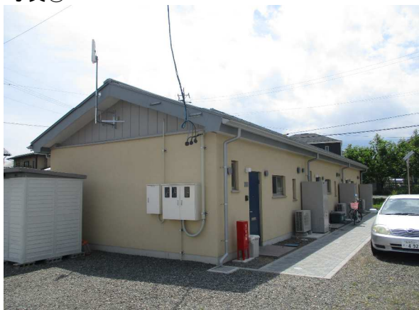
改修棟北東面
