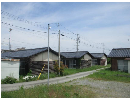
全景 南東面より
