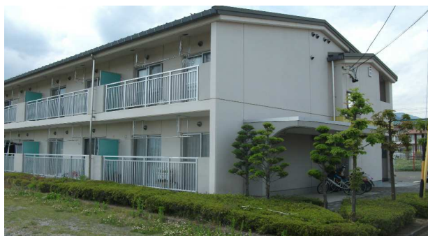
E棟南東面
