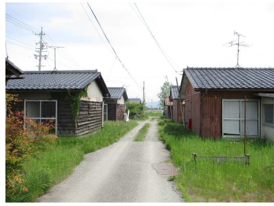
団地内通路 南面より
