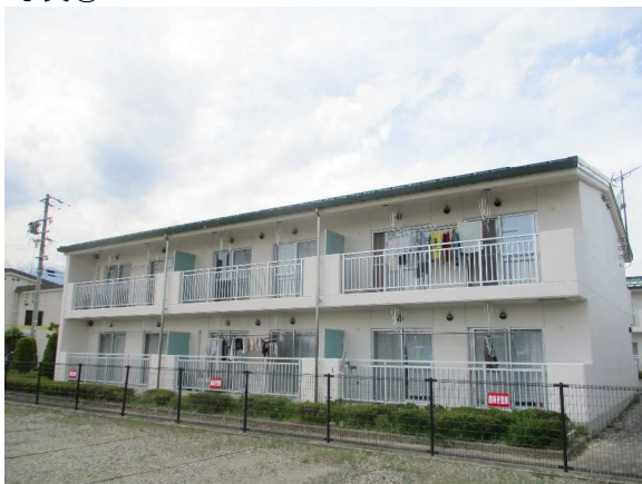
F棟南西面
