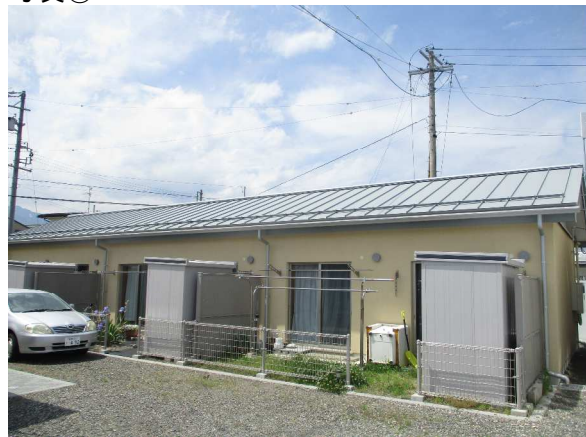
改修棟南東面
