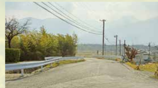
国道19号から松糸道路へのアクセス道路を整備
