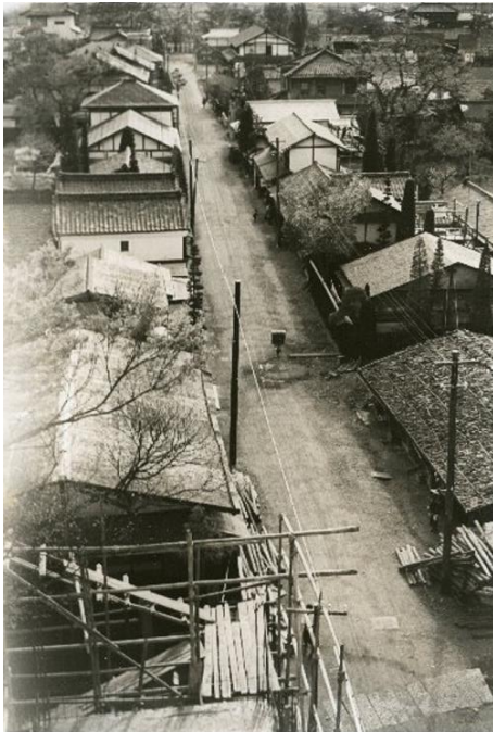
写真 4-3 舗装前の豊科駅前通り (昭和 20 年代頃か)
