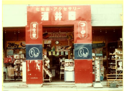
写真5-3 酒井屋洋品店 (新店舗工事のため仮店舗)
