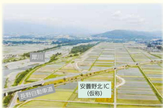
犀川右岸 安曇野北 IC(仮称) 5月時点 水路の付替え完了
