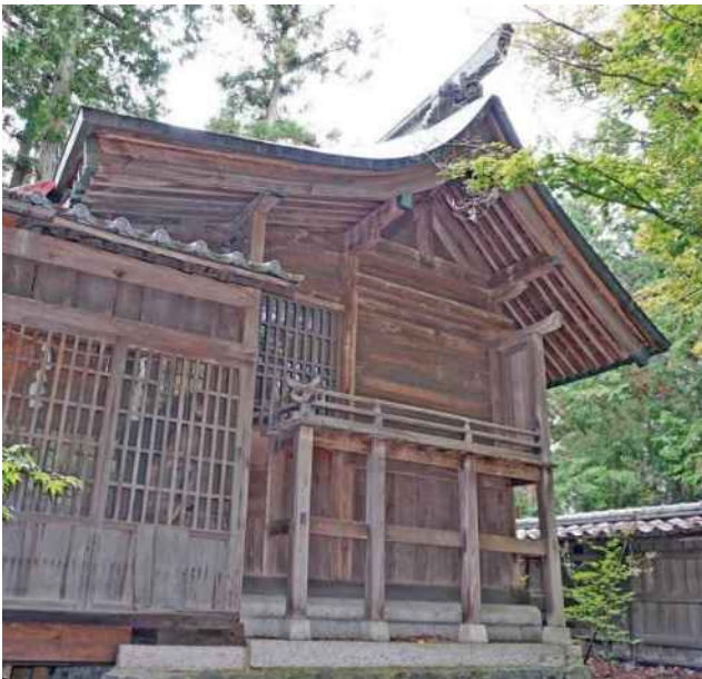
真々部の諏訪神社本殿（妻面）
