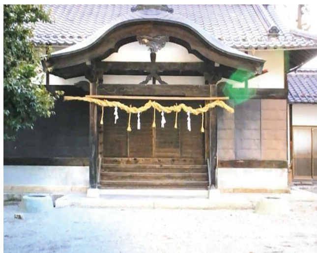
社務所玄関の左右にある「屋根の雨水受け」：じつは旧木造鳥居の土台だった
