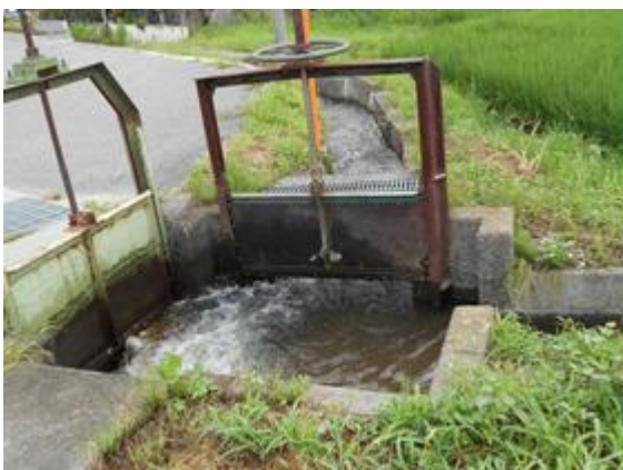
(北へ流れる寺所新堰と権現堰が交差する場所)
