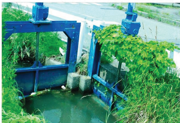
インター南交差点の南西の排水路とゲート (右側のゲートを上げる中曽根川へ放流する)
