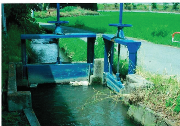
平林精米所東の排水路とゲート (右側のゲートを上げると中曽根川へ放流できる)
