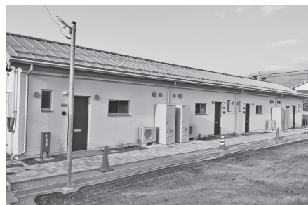
リノベーションが終了した市営穂高団地
