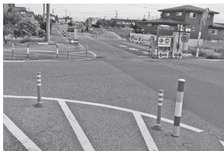
1 級 26 号線の吉野線と交差付近の工事現場
