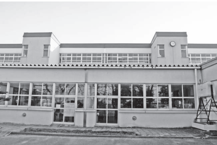
改修が予定されている豊科南小学校
