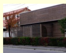
室外機に囲いを設置
