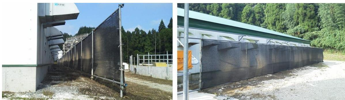
写真 排気口への遮蔽壁の設置
