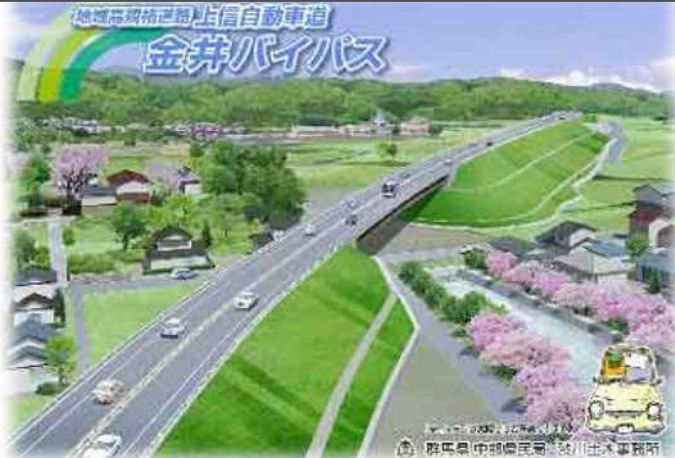
上信自動車道 (国道145号等) 群馬県HPより
