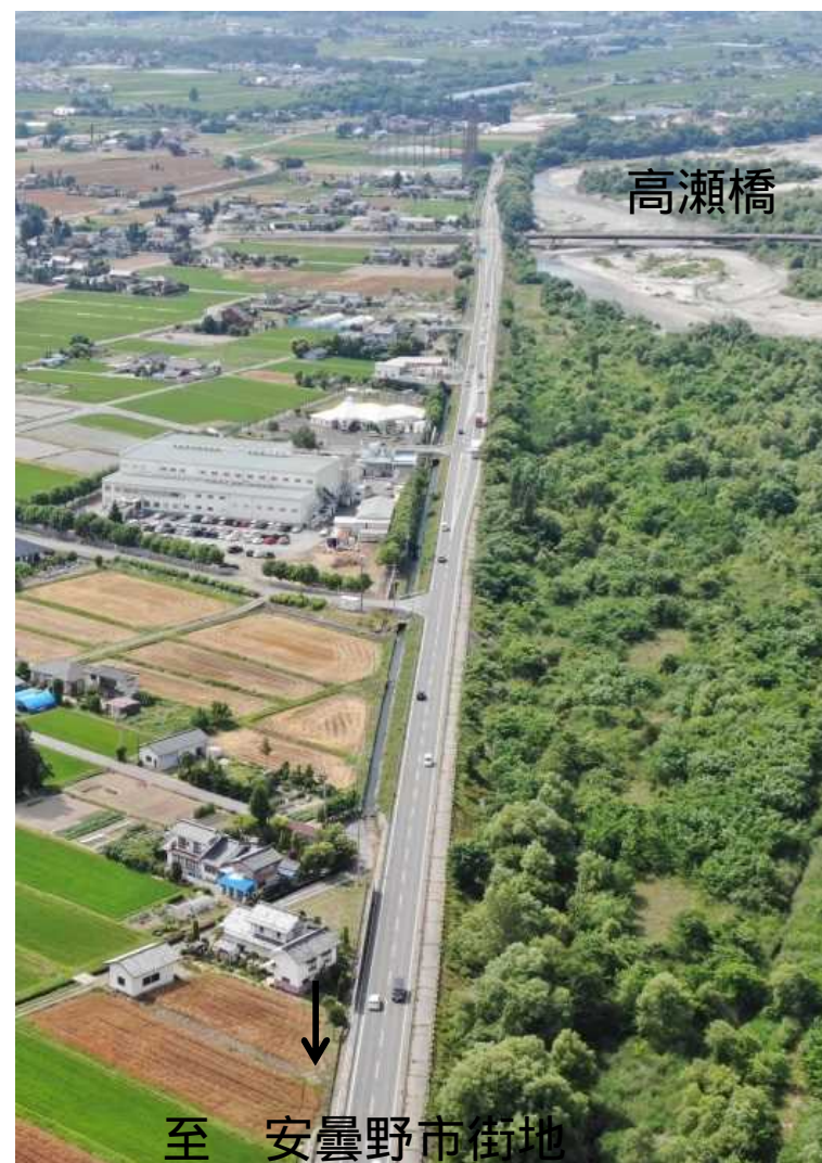
高瀬川右岸道路
