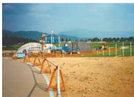
工事中の公園。奥には公園の目玉であった大型遊具（設置当初のもの）が見える
