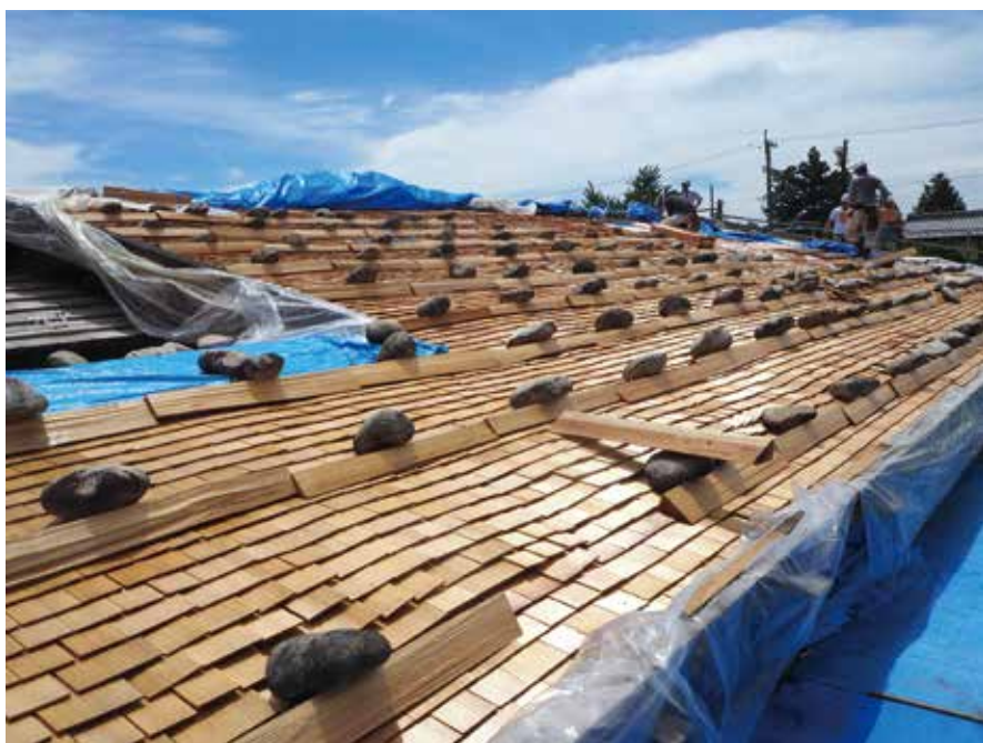
国の重要文化財曾根原家住宅における屋根の吹替えの様子（2018年） かつてはこのような板屋根がみられ、水に強いサワラが多く用いられた
