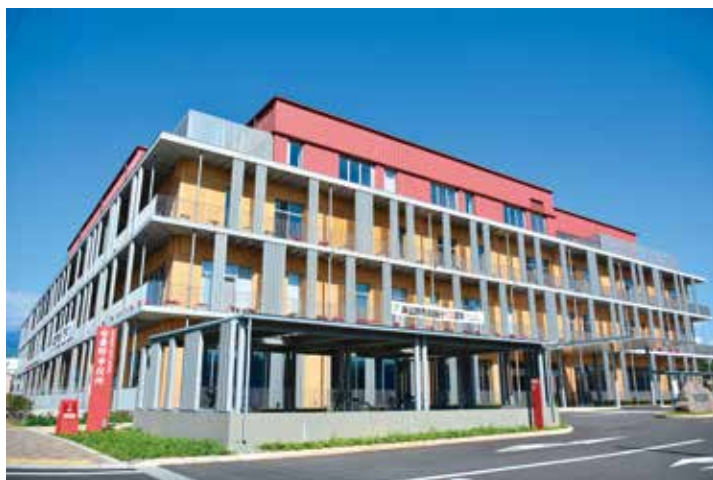
本庁舎外観（正面玄関）
