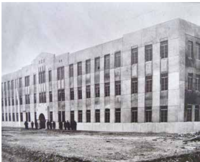
大正13年に竣工した豊科高校校舎
