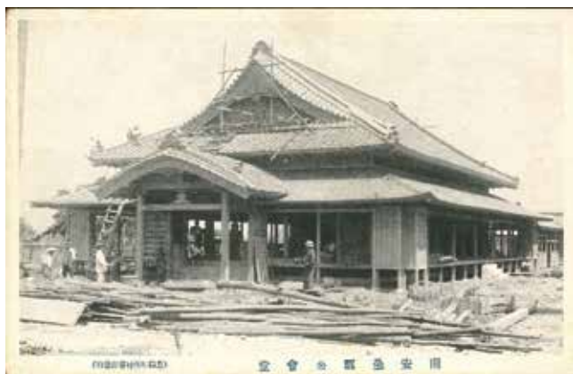
建設中の南安曇郡公会堂
