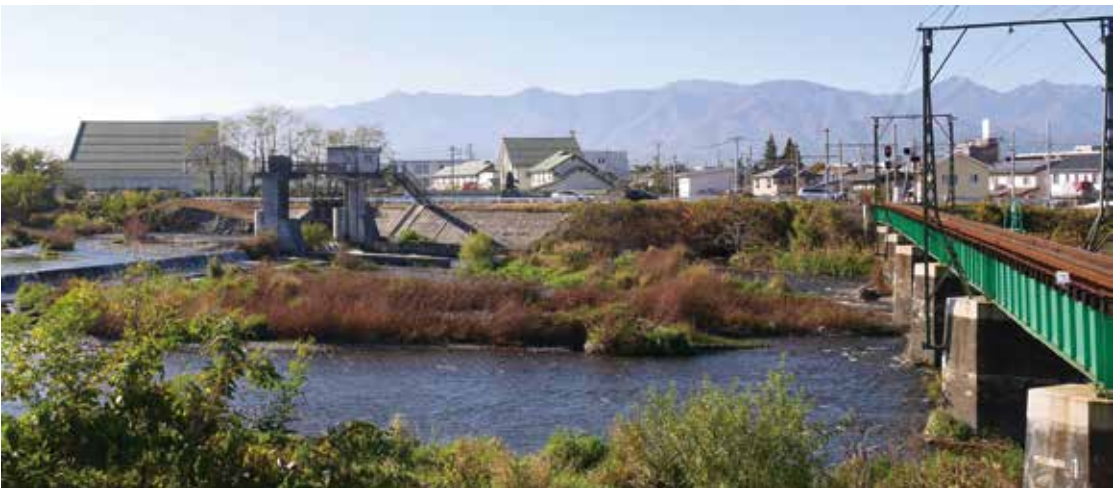
勘左衛門堰の取入口（松本市荒井）
