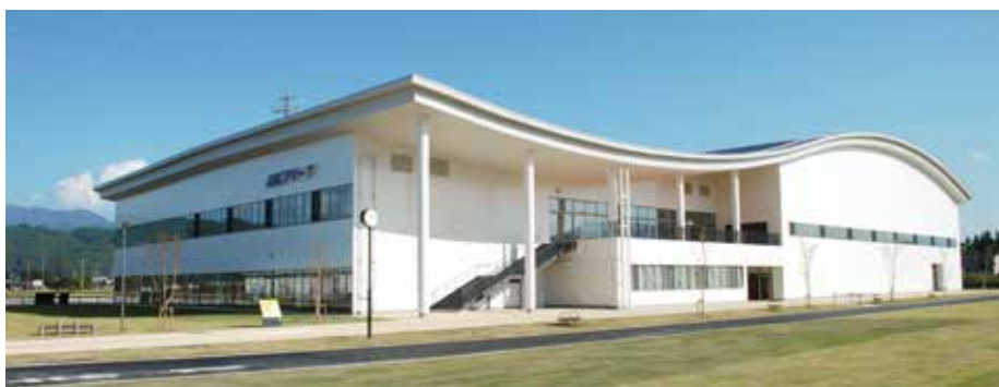
豊科南部総合公園南側に完成した ANC アリーナ
