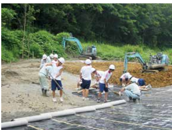
ビオトープ池のシート張り
