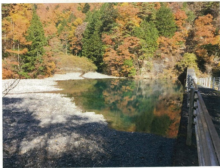
①最上流の堰堤プール
