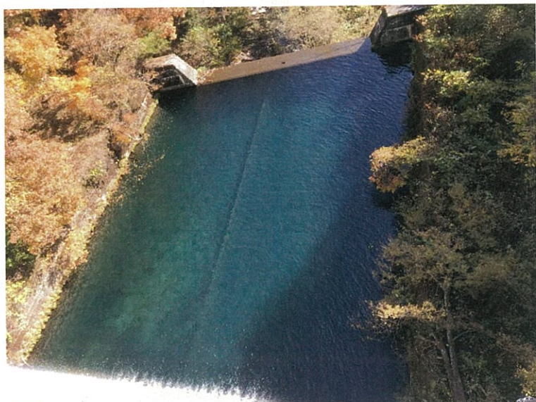
③2番目の堰堤プール
