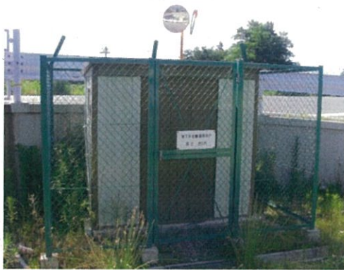
地下水位観測箇所
