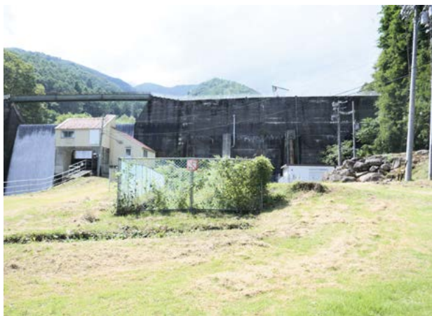
須砂渡水力発電所。砂防ダムの右側に短い水圧管路、その下の発電所が見える
