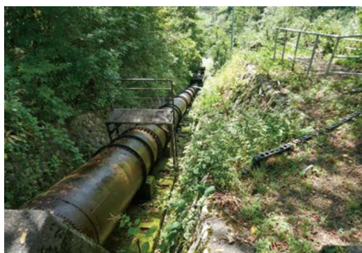
烏川第2発電所の水槽（上）と水圧管路（下）
