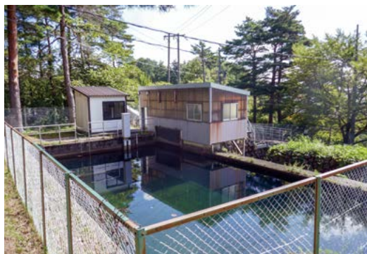
烏川第2発電所の水槽（上）と水圧管路（下）
