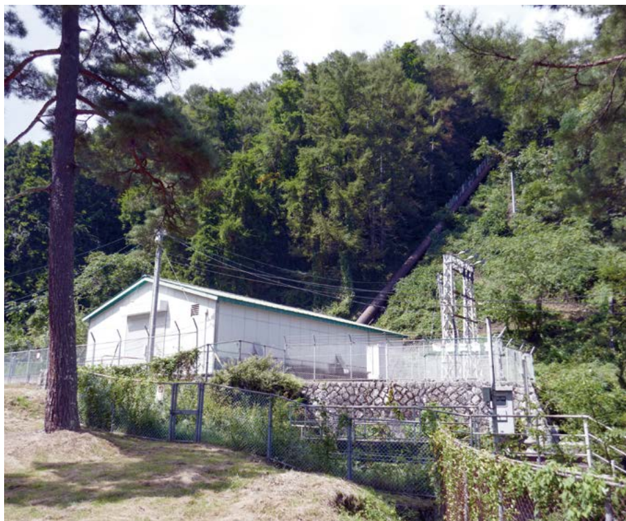
烏川第1発電所。手前の建物が発電所。背後に水圧管路が見える
